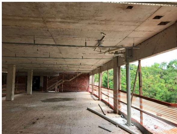
07 – Tubulações de esgoto sanitário, canaletas iluminação.
