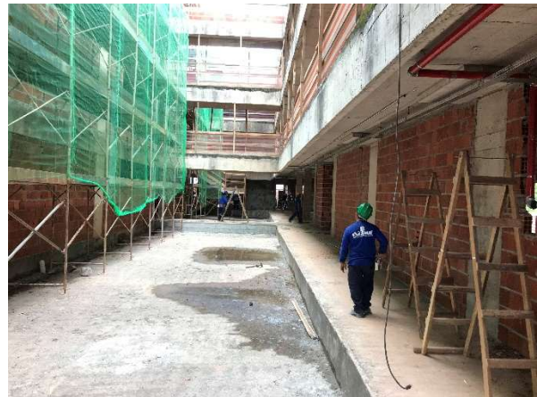
08 – Andaimos, alvenarias, tubulação hidrante, calhas de instalações elétricas.
