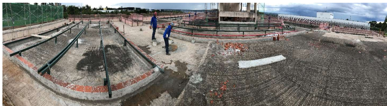
04 – Estrutura metálica da cobertura, fixada.
