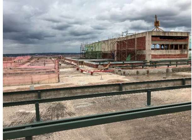
06 – Estrutura do telhado, tubulações de hidrante
