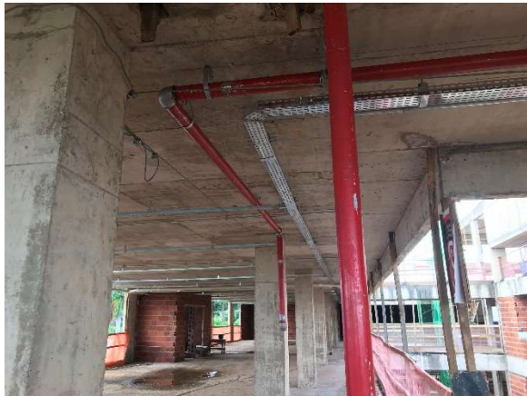
13 – Calhas de instalações elétricas, alvenaria, tubulação de hidrante, 2ºpav.
