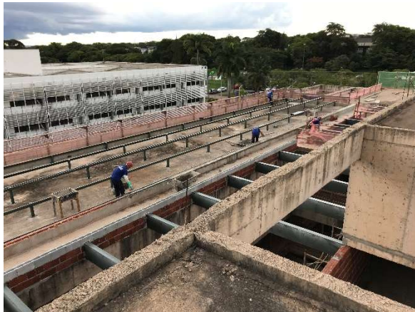
05 – Estrutura do telhado e pergolado.
