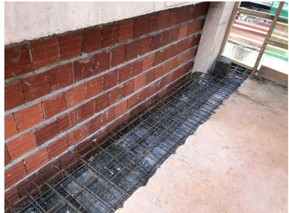
14 – Armação de estrutura de complementação para fechamento de escada.
