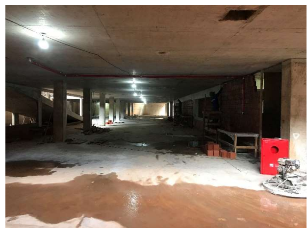
10 – Alvenarias, tubulação de hidrantes, piso do 2ºSS
