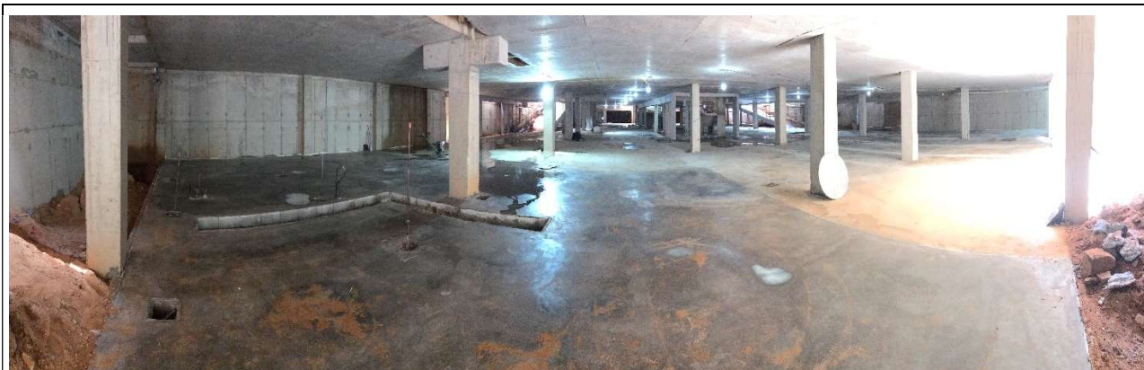
01 – Piso da garagem 2º SS, concretado.
